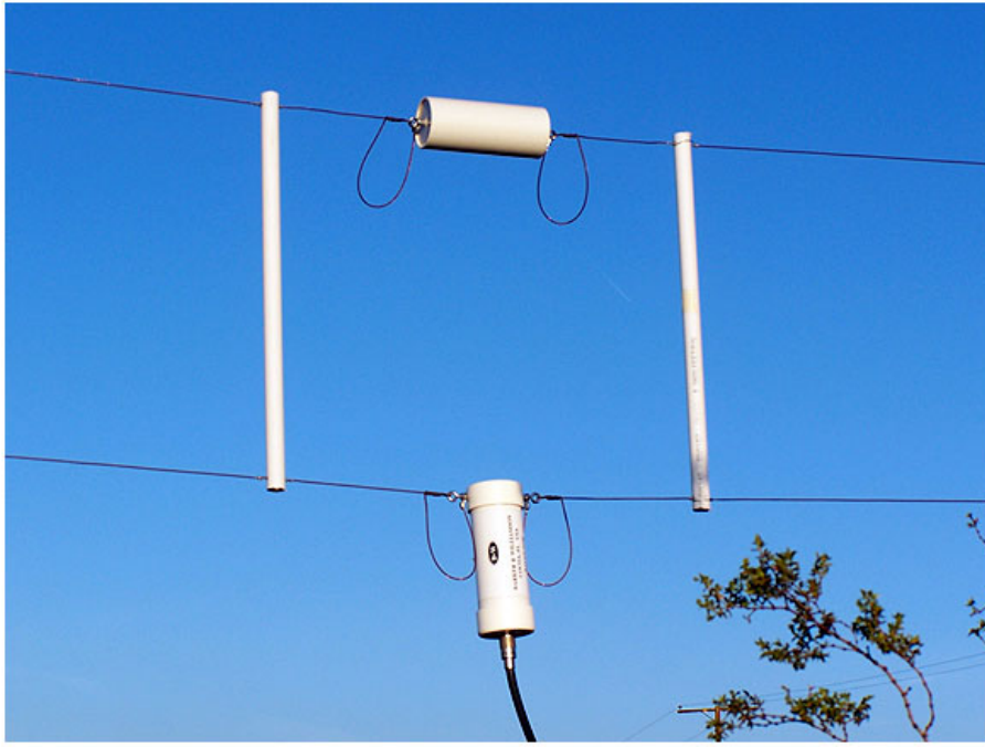
Un primer plano de la terminación resistiva y balun.
