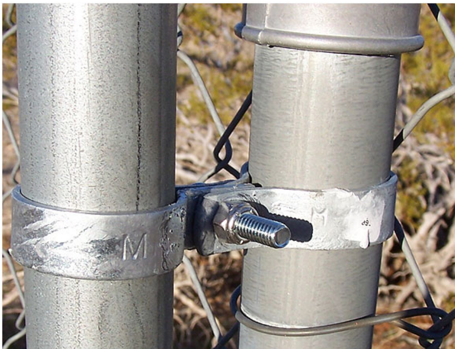
Los pernos enchapados y las tuercas de tope con inserto de nailon sujetan bandas separadas que rodean cada tubo de forma independiente.
