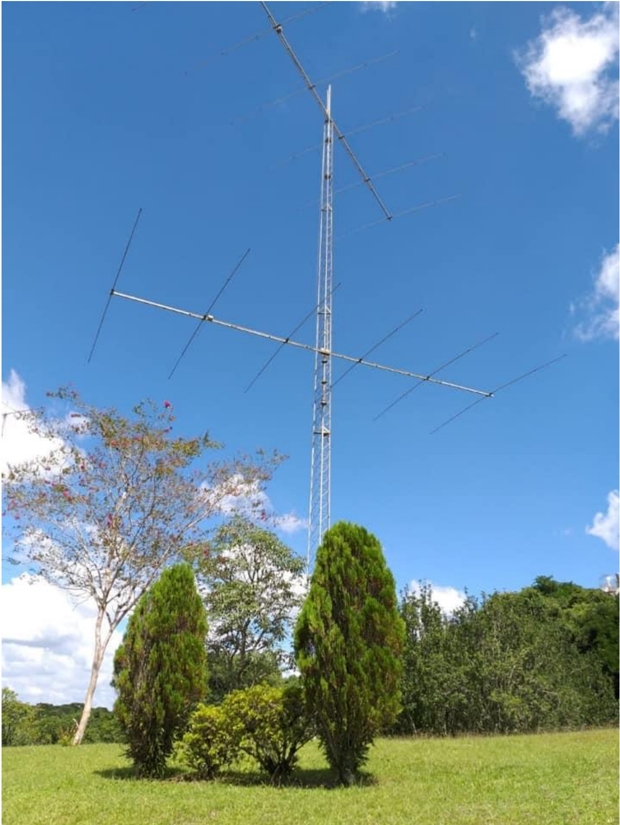
Fotografía 08: Antenas para la banda de 20 metros, 6 sobre 6 apilados, pluma de 20 metros de largo, torre de 30 metros de altura auto elevada
