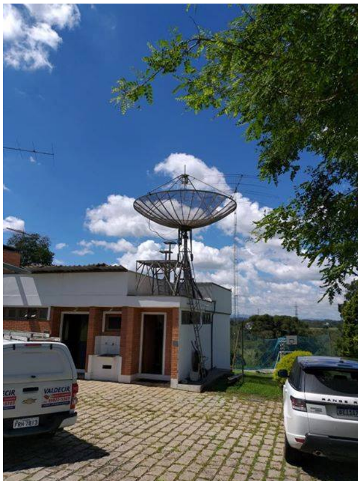
Fotografia 06: Antena Moon Bounce (Parabólico de 6 metros - EME 144 Mhz)
