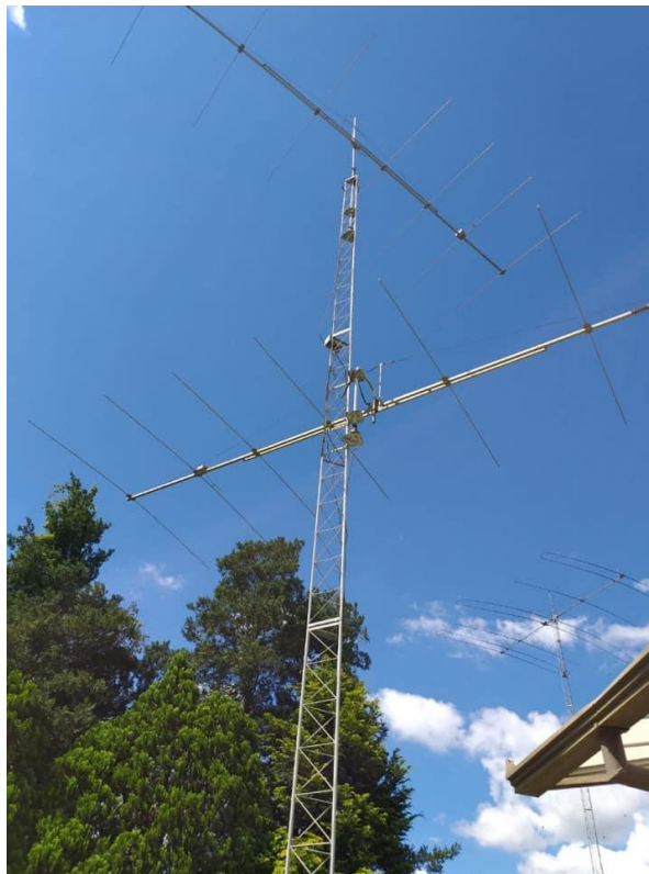
Fotografía 04: antenas de 20 metros 6 sobre 6 apilados, pluma de 20 metros de largo, torre de 30 metros de altura
