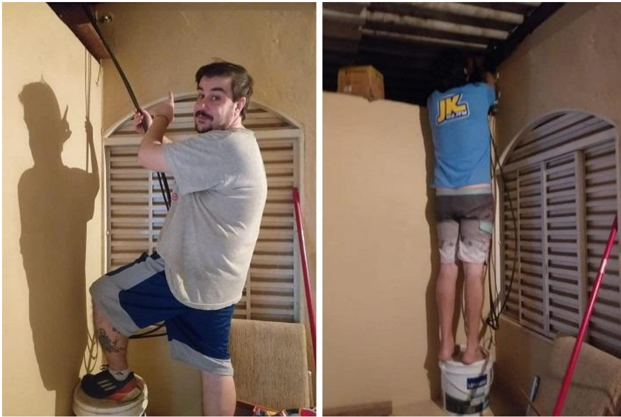
Fotografías 32: Martin y Mark, pasando los cables coaxiales por el interior de la casa
