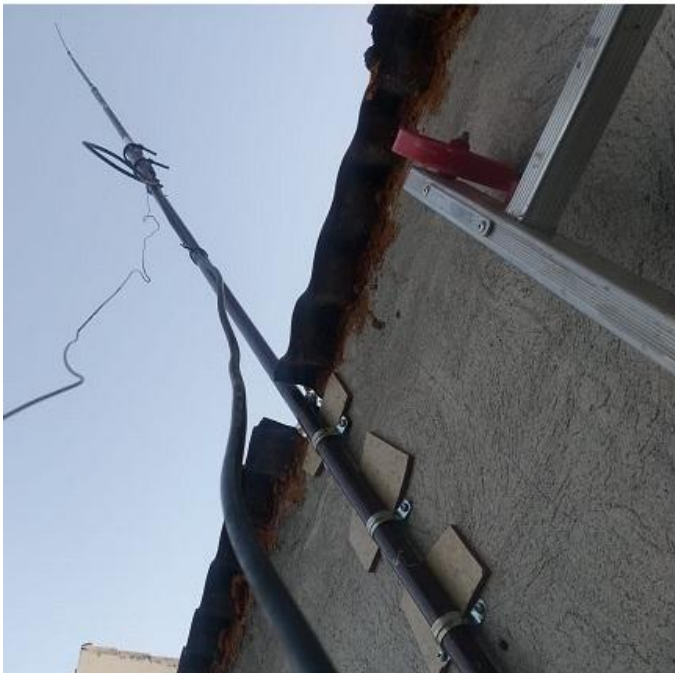
Fotografías 29: la primer antena instalada fue la antena vertical Antron 99, bada de 10 Mts y 11 Metros banda ciudadana
