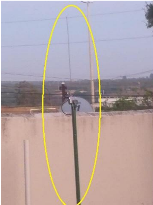
Fotografías 30: la segunda antena instalada fue la Antena de base Vhf 1/4 de Onda, en la parte trasera del techo de la casa
