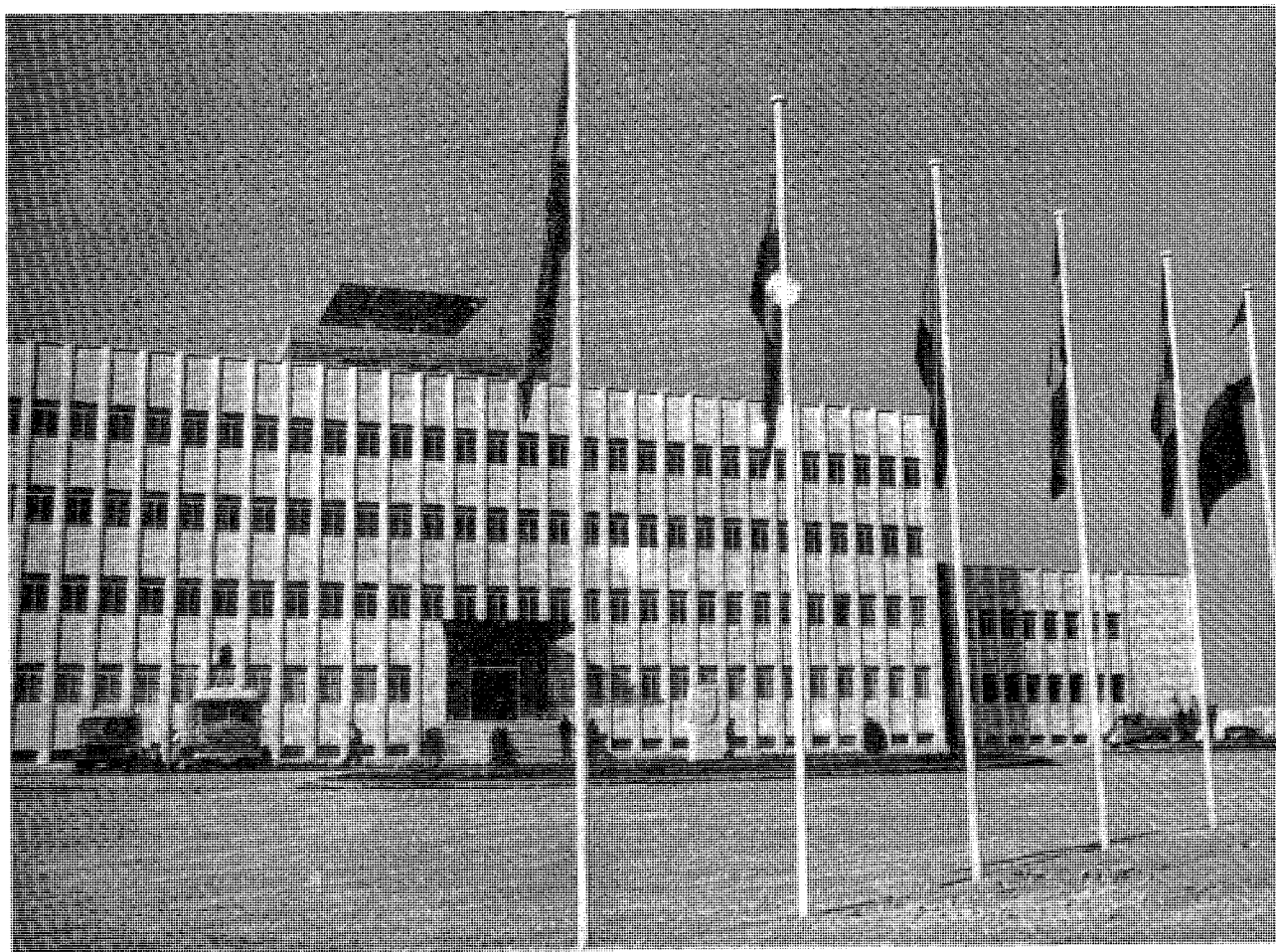
Nuevo edificio del centro de producción de programas de Prado del Rey.
